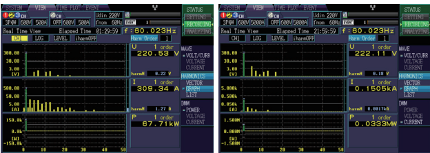
설치 전 : 고효율 몰드 600 kVA
